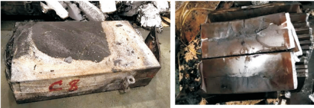
图 13 C8 电容器解体 Fig. 13 Disassembly of C8 capacitor
